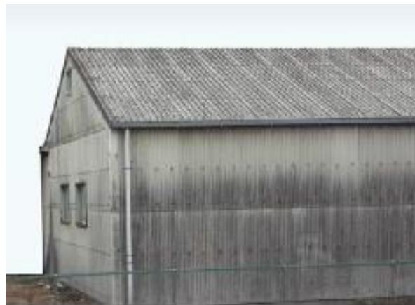
石綿含有スレート波板（屋根・外壁）
