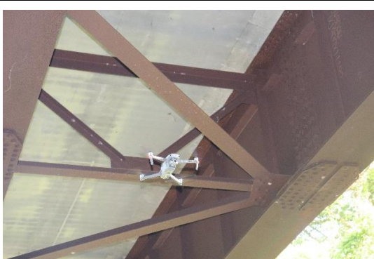
ドローンによる点検例
