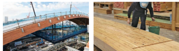
約90mの梁(はり)は、国産のカラマツ集成材に職人の手を入れながら製作。
