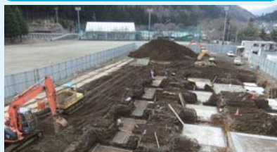
基礎工事が始まりました
